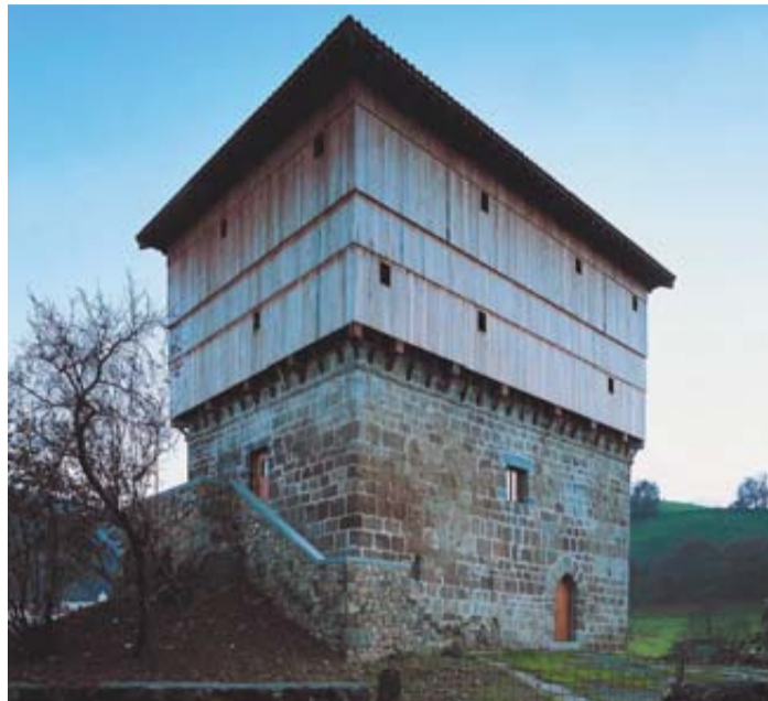
TORRE JAUREGIA. Rehabilitada por Maite Apezteguía en Donamaría. Un "modelo de rehabilitación cuidadosa y sensible que considera el edificio como un legado que se debe recuperar, fijar y potenciar". DN
